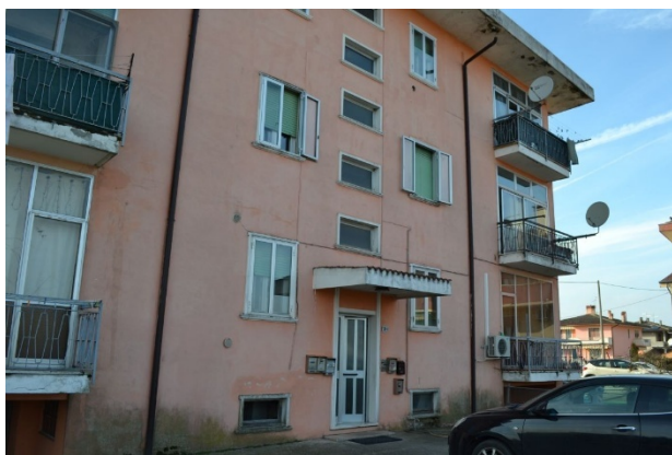
foto 1 - il perimetro della proprietà condominiale, lungo i confini della corte comune esterna, non è visivamente protetto da cortine di alcun tipo. In copertura, gli sporti di gronda lordi raggiungono circa il metro e venti, evidenziando marcato deperimento all'intradosso. I tetti sono a padiglione, con quattro giaciture di falda utili. Tutte le unità sono munite di poggiole verso est
